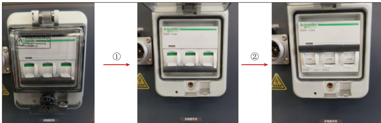
图 2-1 系统上电步骤示意图
